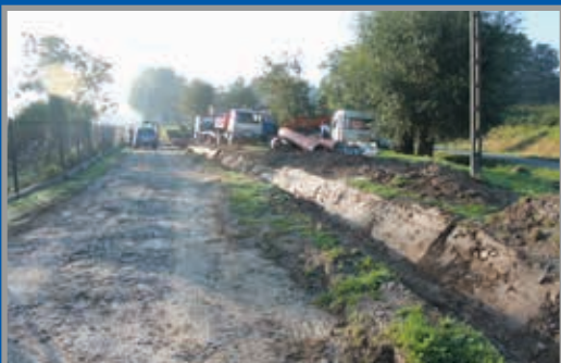
Droga Spółdzielcza w Głuchowie – w trakcie i po remoncie
