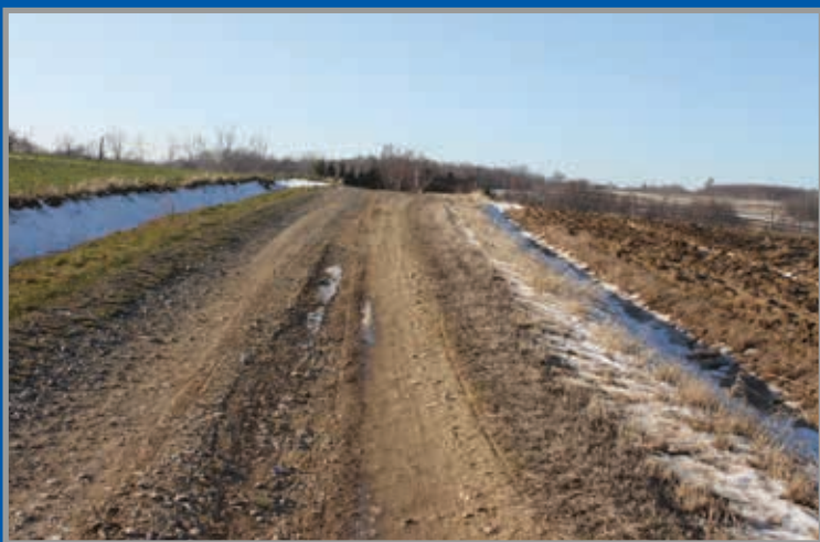
Droga „Na okop” w Handzlówce przed i po przebudowie
