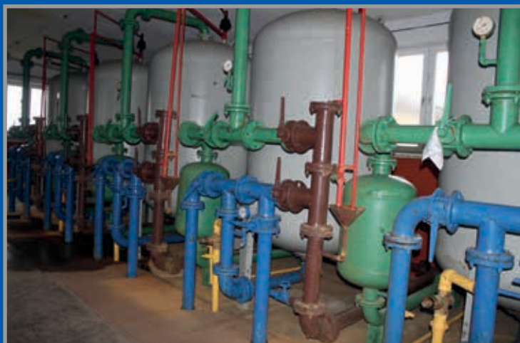
Stacja Uzdatniania Wody w Kosinie przed i po przebudowie
