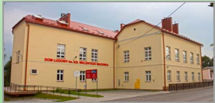
Rozbudowa i modernizacja Domu Ludowego z przedszkolem
