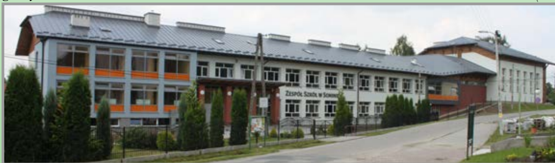
Rozbudowa i przebudowa obiektu Zespołu Szkół w Soninie
