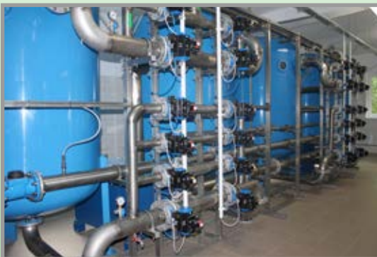
Przebudowa i rozbudowa Stacji Uzdatniania Wody w Albigowej
