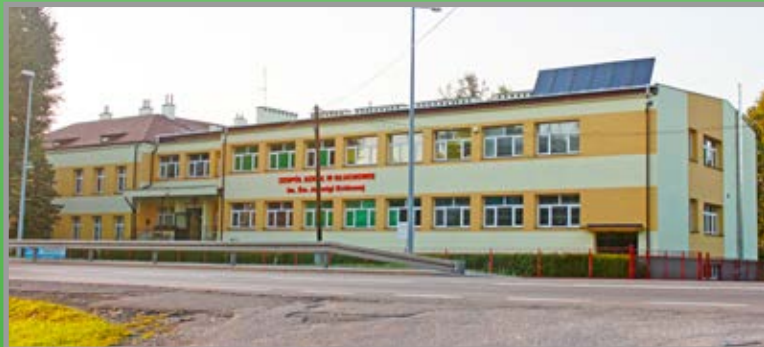
Termomodernizacja i remonty obiektów szkoły
