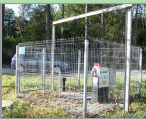
Budowa sieci kanalizacyjnej – 35 km sieci, 351 przyłączy, 19 pompowni lokalnych, 4 pompownie ścieków
