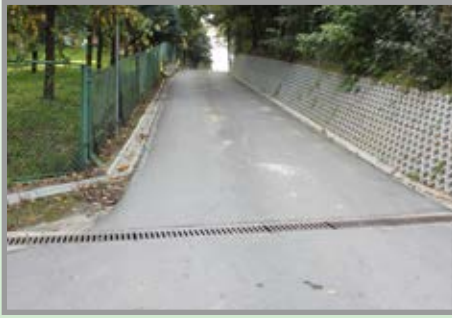
Droga „Małe Doły”
