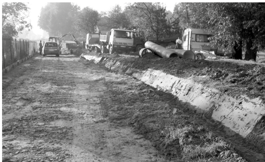
Droga „Spółdzielcza” w Głuchowie w trakcie budowy, fot. archiwum UG
