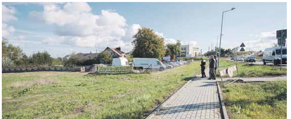
(KB) Wybudowane drogi mają stworzyć komunikacyjną całość z przebudowaną DK 94 FOT. KINGA BALAWĘJDER
