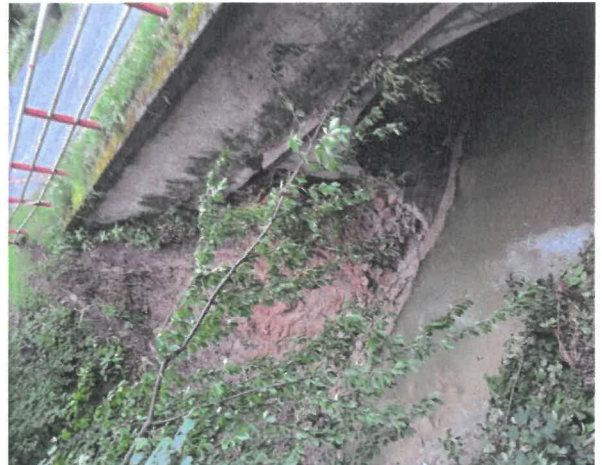
Rozmycie skarpy lewej przed mostem
