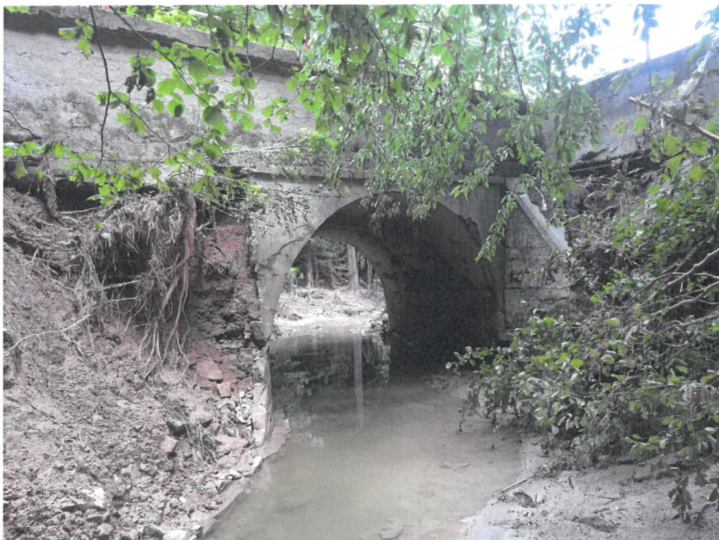
Obiekt od strony wody
