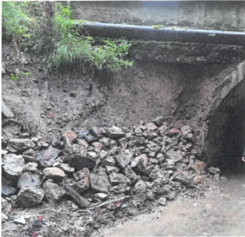
Rozmycie skarpy prawej za mostem
