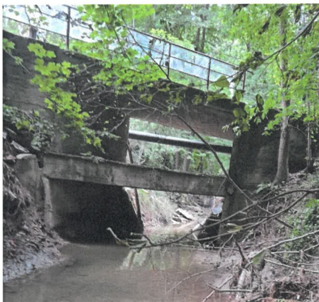
Widok obiektu położonego kilkadziesiąt metrów w górę rzeki. Podmycia, obsunięcia, podparcia elementów betonowych/żelbetowych drewnianymi żerdziami.
