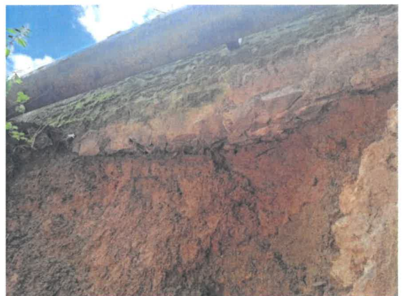
Rozmycie skarpy lewej przed mostem
