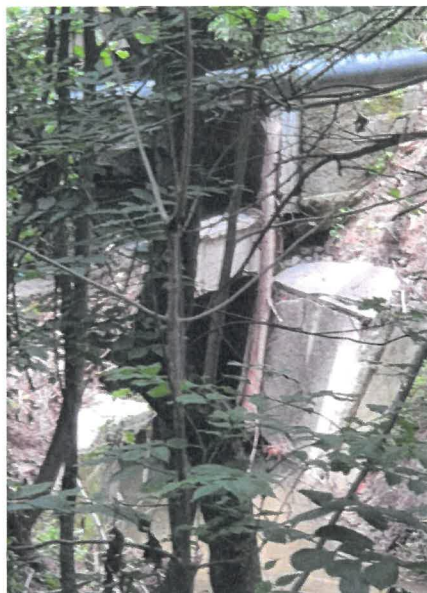
Widok obiektu położonego kilkadziesiąt metrów w górę rzeki. Podmycia, obsunięcia, podparcia elementów betonowych/żelbetowych drewnianymi żerdziami.
