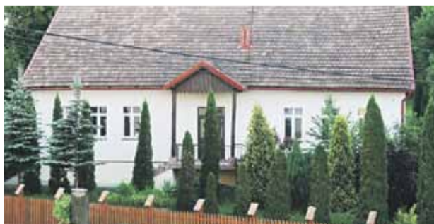
W tym budynku powstanie żłobek w Kraczkowej
