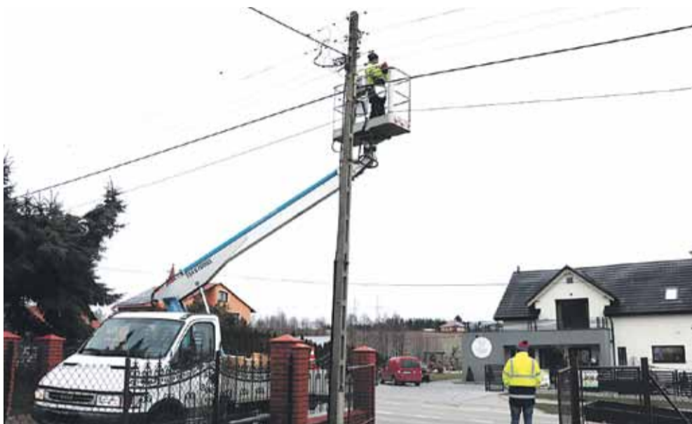
Montaż nowego oświetlenia rozpoczął się początkiem lutego FOT. BERNADETA BRÓZ
