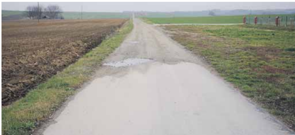
Droga Albigowa Granice zyska nawierzchnię asfaltową na długości 2,6 km, chodnik o dł. ok 0,5 km oraz na całej długości drogę rowerową o nawierzchni asfaltowej
