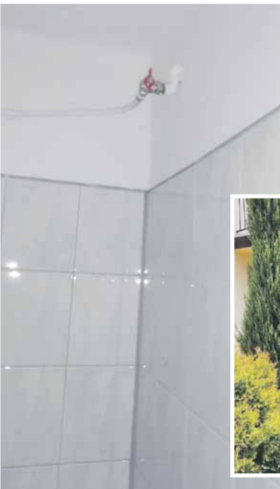
Trzeba było m.in. wymienić instalację sanitarną
