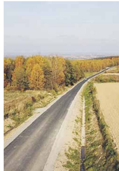
Przebudowany odcinek drogi jest dla naszej gminy dogodnym połączeniem z Rzeszowem FOT. BERNADETA BRÓZ, SZYMON NOWAK
