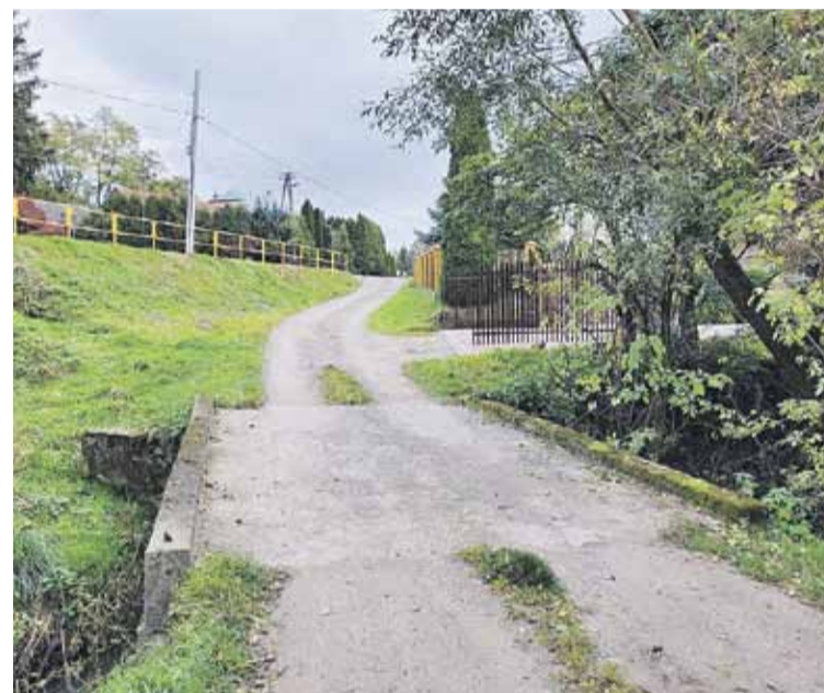
Droga przed przebudową FOT. UG ŁAŃCUT
