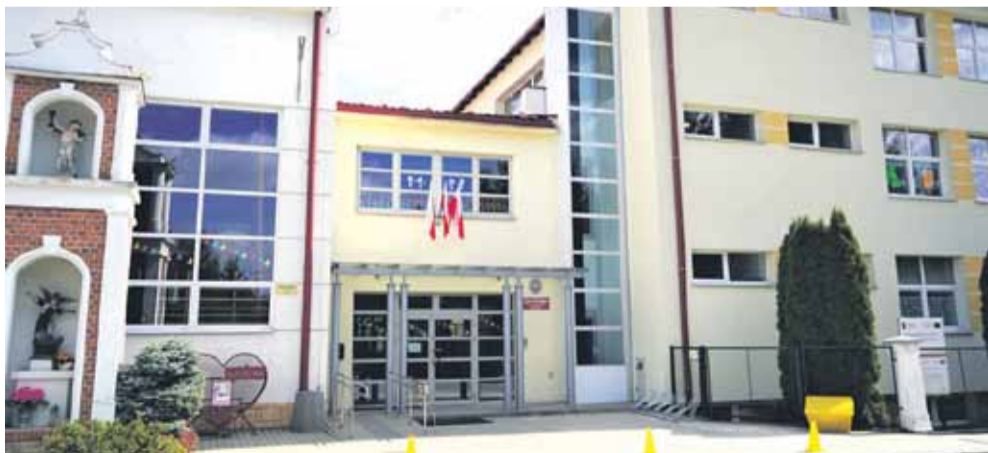
Zakończyły się prace związane z budową windy zewnętrznej oraz modernizacją toalet w Zespole Szkolno-Przedszkolnym w Albigowej. - Połowę kosztów tego zadania sfinansowaliśmy ze środków pozyskanych przez gminę z Państwowego Funduszu Rehabilitacji Osób Niepełnosprawnych – mówi wójt Jakub Czarnota FOT. SZYMON NOWAK
