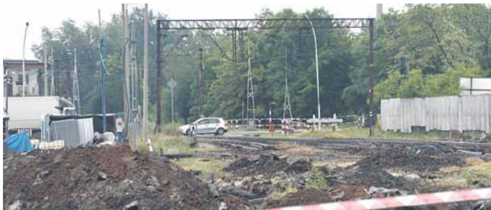
Wybudowany obiekt będzie dwupoziomowy i pozwoli na swobodną komunikację pod torami samochodów do wysokości 4,60 m
