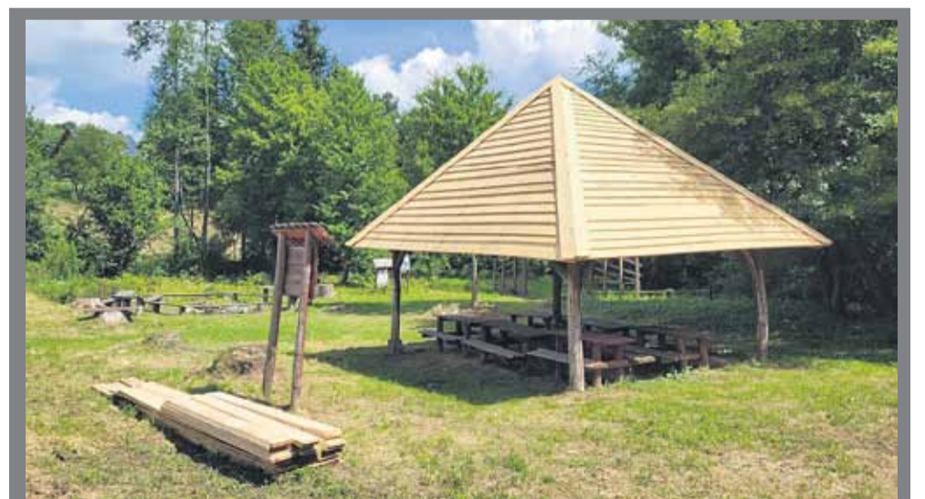
CIERPISZ. Zakończyła się wymiana dachu altanki przy Ścieżce Koralewej. Trwają też prace porządkowe. To efekty współpracy Gminy Łańcut, Sołectwa Cierpisz i Nadleśnictwa Kańczuga FOT. KINGA BALAWĘDER
