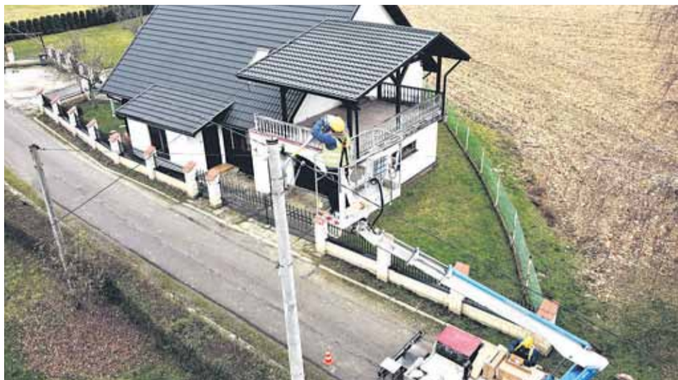
Modernizację oświetlenia drogowego gmina rozpoczęła pod koniec 2019 r.
